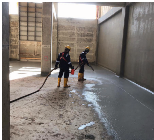
Raffineria rapida Pengerang, Malesia: Rinnovo di serbatoi con Sikalastic®, impermeabilizzante cementizio (applicazione spray), nastri Sikadur® Combiflex® SG e Sikaflex® PRO-3.
