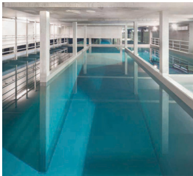
Impianto di trattamento dell'acqua potabile di Kluizen, Belgio: Sikalastic® M 808
